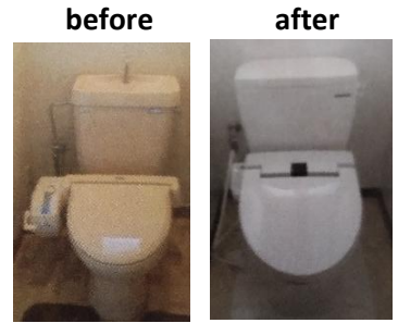
トイレ工事なら、ぜひ当社へ!
